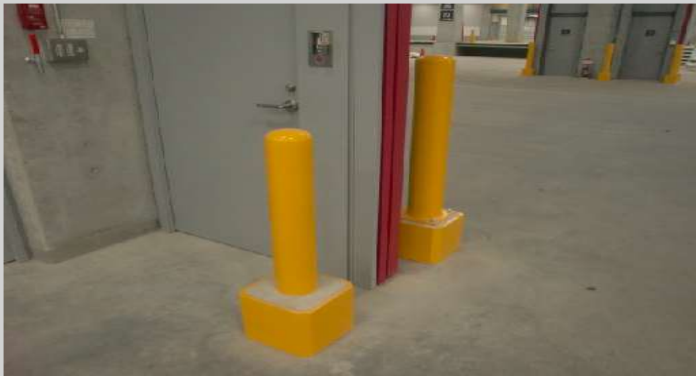
ガードポール用鋼製型枠取付例
